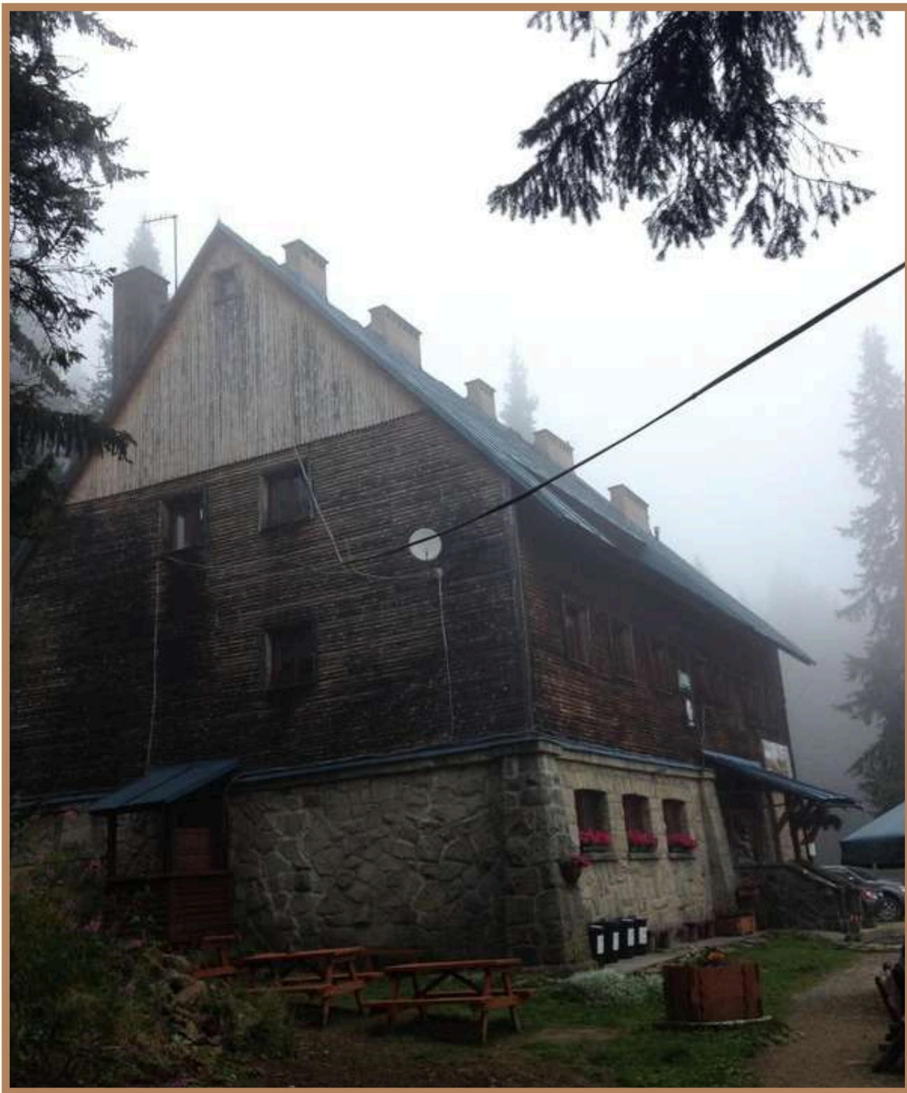
Schronisko przed remontem
